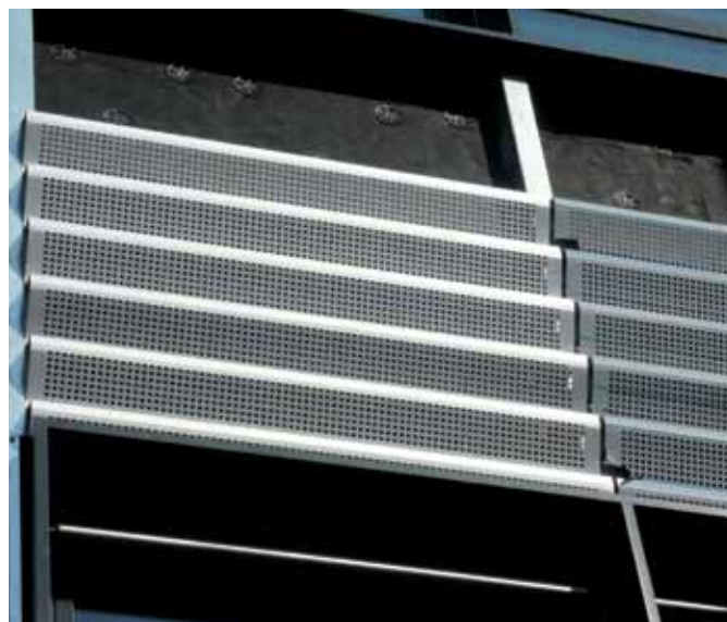
[1] Dettaglio di facciata ventilata
