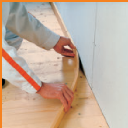
Posare le strisce isolanti per i bordi e unire testa a testa negli angoli
