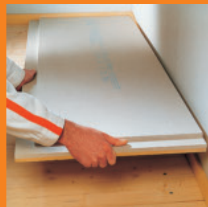
Posare le lastre per sottofondo FERMACELL
