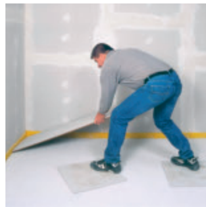
Posa di FERMACELL lastre per sottofondo su FERMACELL livellante granulare camminando su "isole di lavoro"
