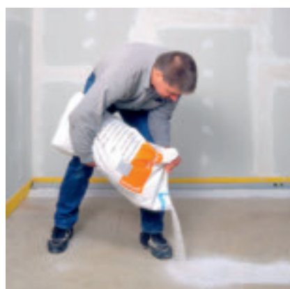
Fig. 2 – Getto delle "strisce d'appoggio" iniziali
