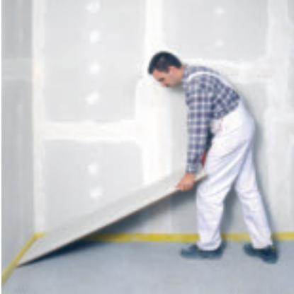
Posa delle lastre per sottofondo FERMACELL
