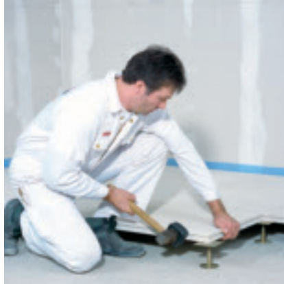
Unire le singole lastre del pavimento sopraelevato FERMACELL MAXifloor
