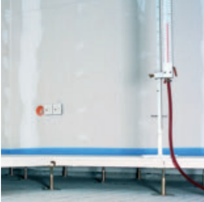
Livellare il pavimento sopraelevato con la livella a tubo d'acqua
