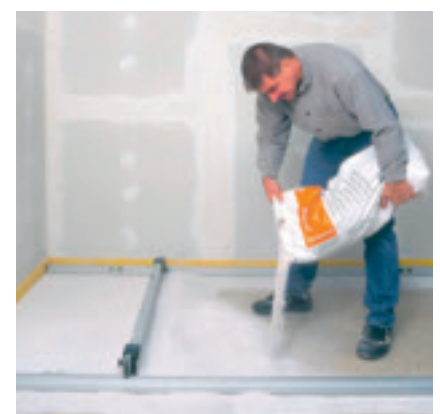
Fig. 3 – Riempimento con il livellante granulare
