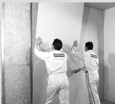
Tamponamento della sottostruttura metallica
