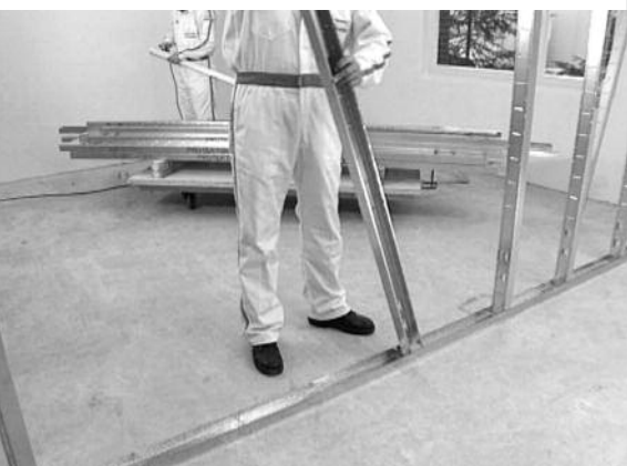
c. Montaggio dei montanti a "C"
