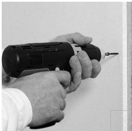
Viti su sottostruttura di metallo
