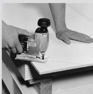
e. Taglio con seghetto elettrico alternativo
