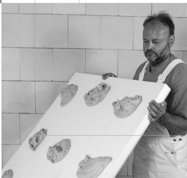
Lastra preaccoppiata FERMACELL: dimensione: 150 x 100 cm = 1,5 m 2 FERMACELL 10 mm + polistirolo espanso rigido
