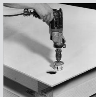
h. Fresatura fori per installazione/passaggio impianti
