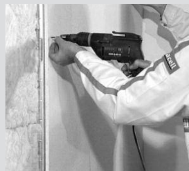
Fissaggio con avvitatore
