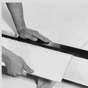
c. Rottura lungo la linea di incisione
