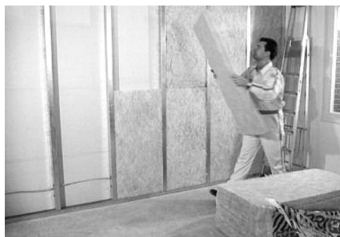
Applicazione del materiale isolante
