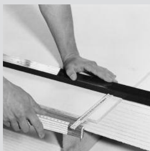
a. Misurazione della linea di taglio
